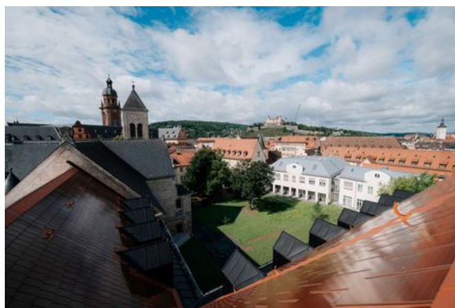
Solarziegel auf dem fertigen Dach; Bild: Bayerisches Landesamt für Denkmalpflege
