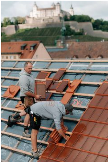
Solarziegel werden auf dem Dach des Klosters der Erlörschwestern gelegt; Bild: Bayerisches Landesamt für Denkmalpflege
